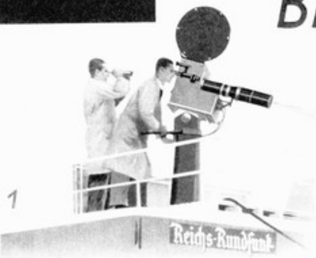
Abb. 1. Der Tonfilmaufnahmewagen des Fernsehsenders ist empfangsbereit zur Aufnahme eines Autorennens. Bild und Ton werden auf einem Filmstreifen festgehalten, der schon in etwa einer Minute entwickelt und sendebereit gemacht werden kann
