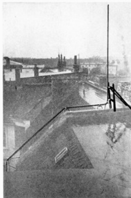
Der Empfangs-„Dipol“ für den GUTHJAHR-Großfernseher Turmstr. 30
